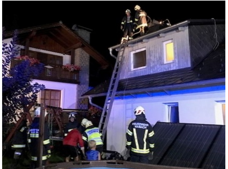
Schubertsiedlung—Wasserschaden am Dach
