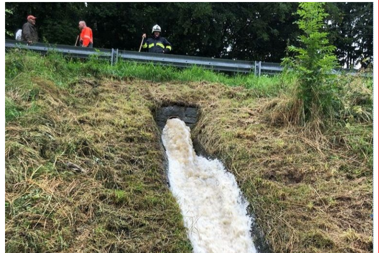
Starkregen im Juli—Überflutung Altenbergerstraße
