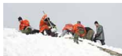
Stets nur mit Sicherung am steilen Dach
